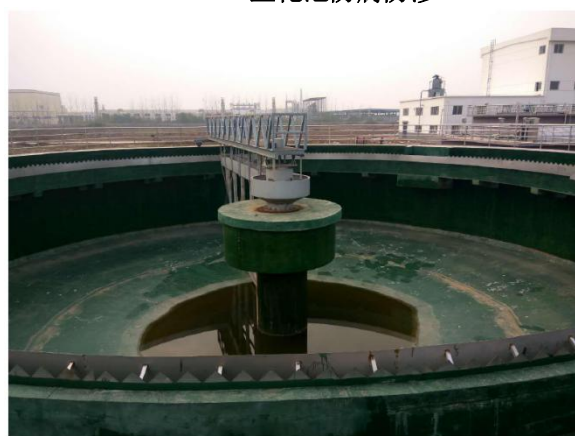
二沉池防腐防渗
