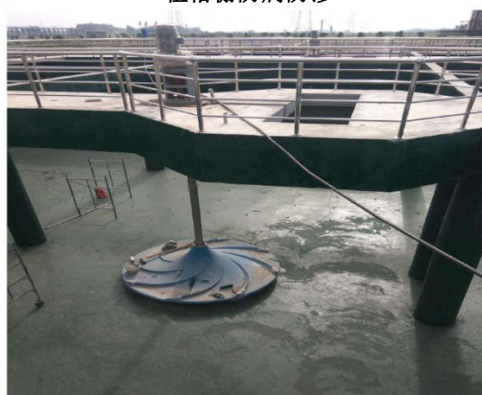
水解酸化池防腐防渗
